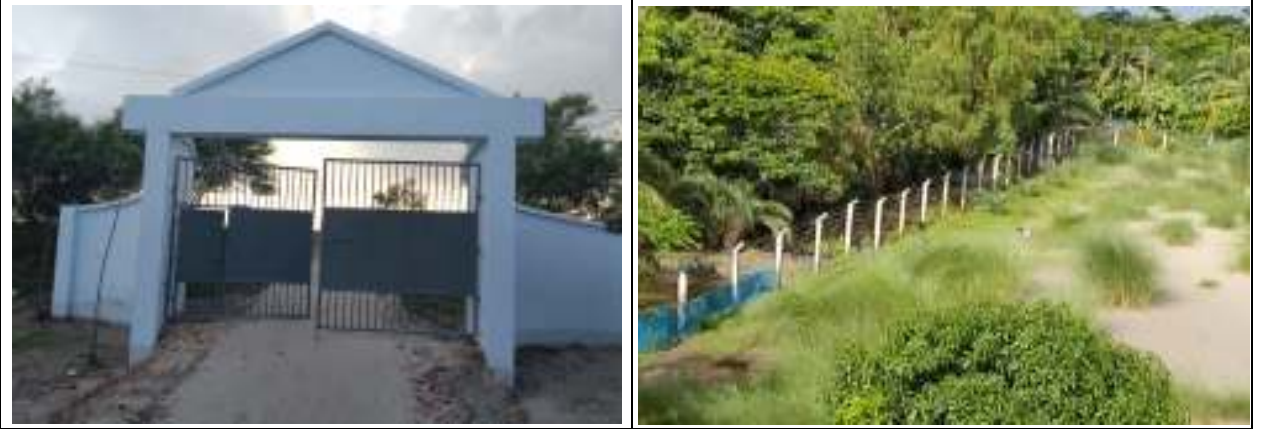
বিসিজি আউটপোস্ট নলিয়ান ও স্টেশন কৈখালীতে ভূমি সীমানা বরাবর আরসিসি পিলারসহ কাঁটাতারের বেড়া স্থাপন
