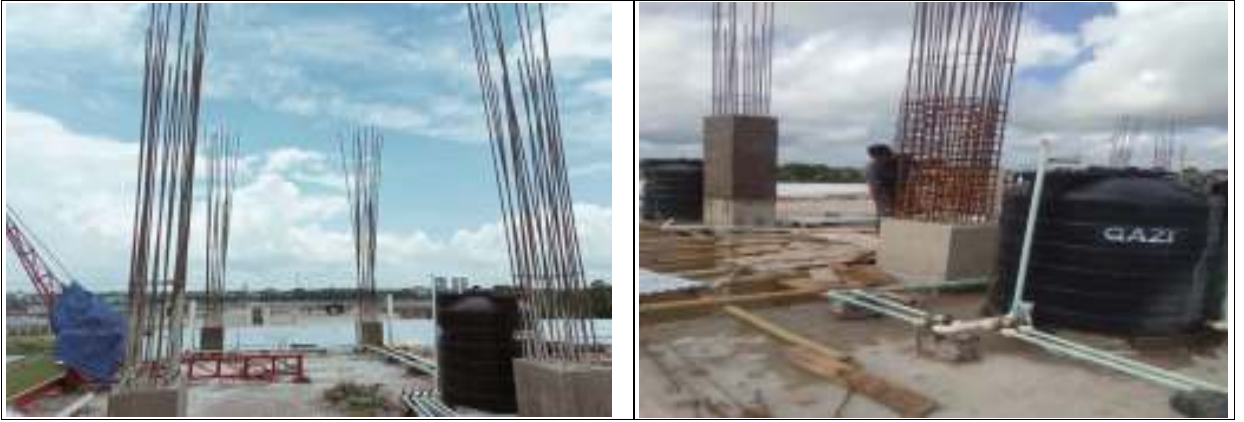
বিসিজি বেইস মংলা এনেক্স এ বিদ্যমান সেইলর্স আবাসিক ভবনের (৫ম হতে ৭ম তলা) উর্দ্ধমুখী সম্প্রসারণ
